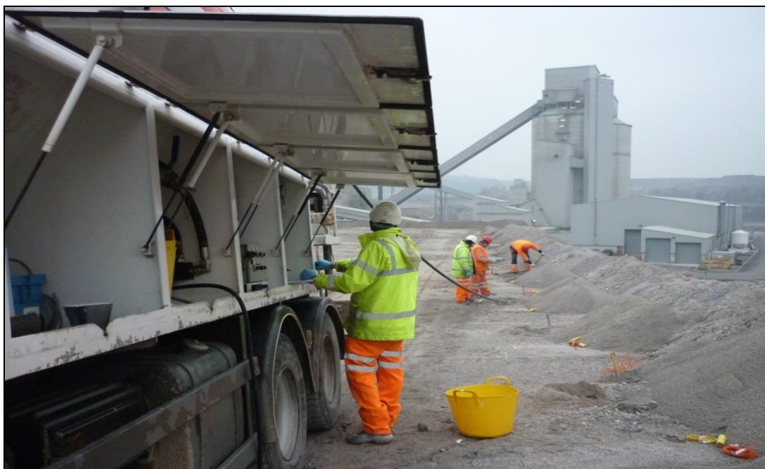
Figura 10 – Carregamento de furo com emulsão
