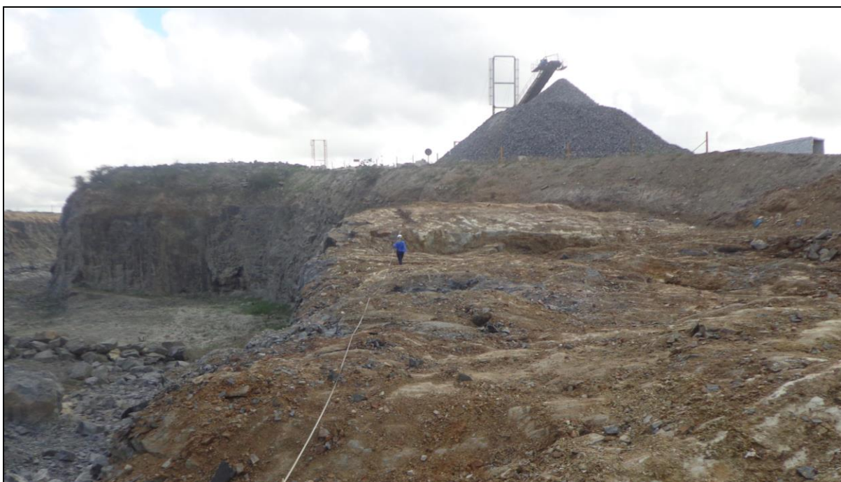
Figura 26 – Marcação dos furos da malha de perfuração
