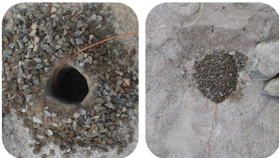
Figura 30 – Tamponamento dos furos
