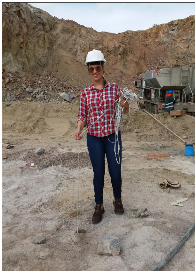
Figura 29 – Aferimento da profundidade do tampão
